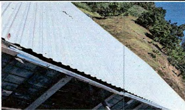
FOTO 1: SUSTITUCIÓN DE CAPOTE DE LÁMINA
