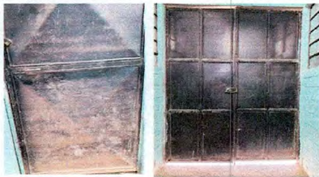
FOTO 5: MANTENIMIENTO DE PUERTA DE METAL
