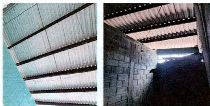
FOTO 8: SUSTITUCIÓN DE LÁMPARAS
