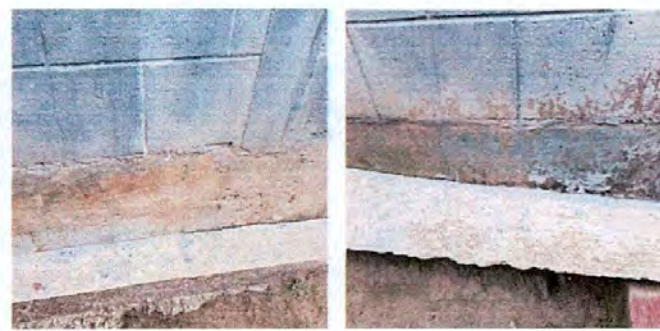
FOTO 12: REPARACIÓN DE BANQUETA DE CONCRETO
