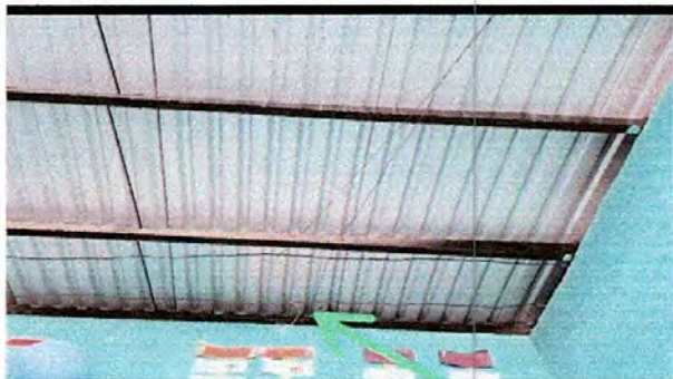
FOTO 7: REPARACIÓN DE SISTEMA ELÉCTRICO
