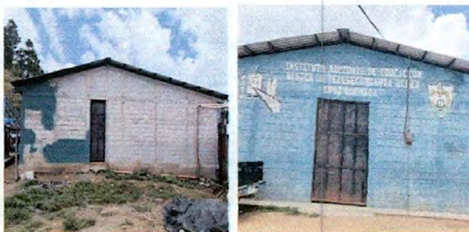
FOTO 11: MANTENIMIENTO DE PARED Y PINTURA
