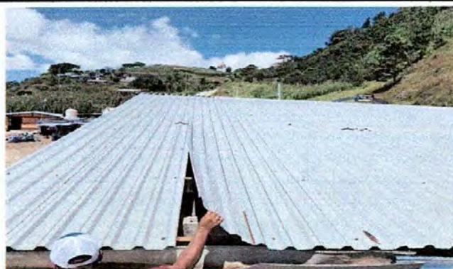
FOTO 2: SUSTITUCIÓN DE LÁMINA
